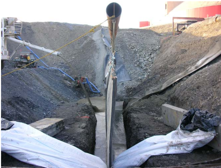
Curtain Wall Control Density Fill Pour
