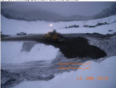
**DESCRIPTION:** DOZER SPREADING SUITABLE FILL AND VIBRATORY ROLLER COMPACTING FILL. FROM WTP LOOKING NORTH.
